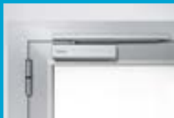
Монтаж на створку двери со стороны петель
